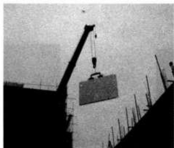
速成墙板吊装中
