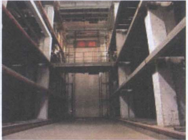
图E10-2 搬运台车通道
