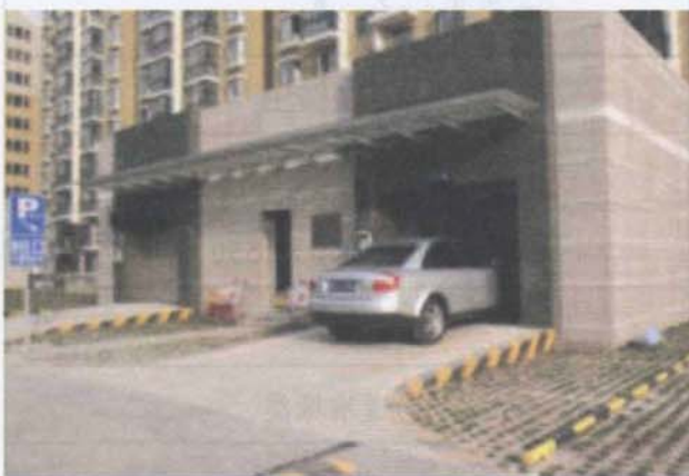
图D1-3 车库出入口（外部）
