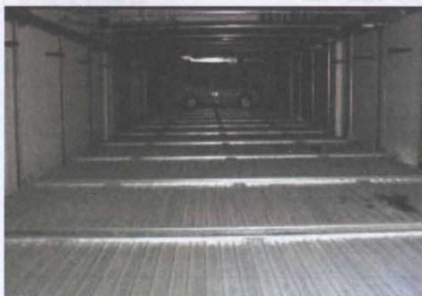
图G1-1 水平循环系统
