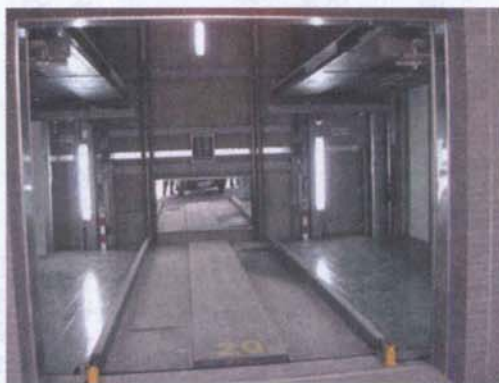
图C3-3 车库出入口(内部)
