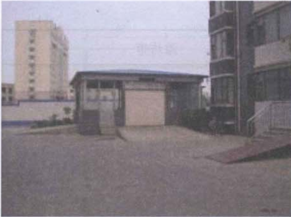
图E5-1 车库出入口（外部）
