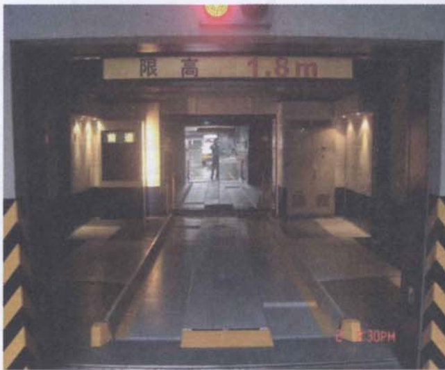
图C7-1 车库出入口(内部)
