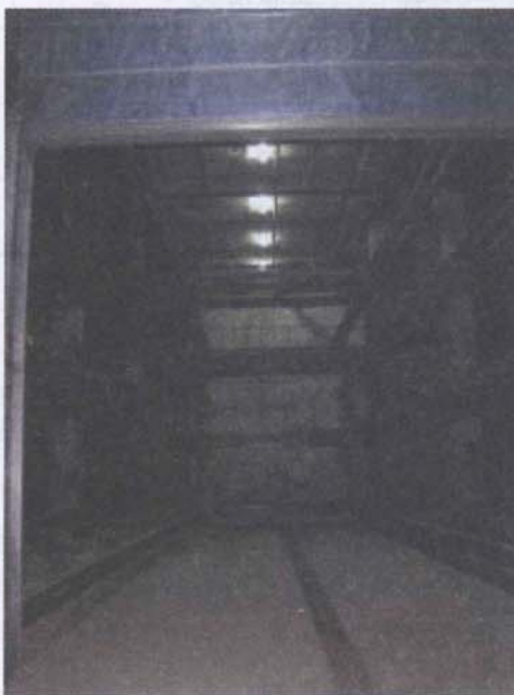
图E5-5 搬运台车运行通道
