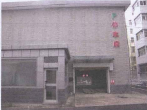
图E10-1 车库出入口
