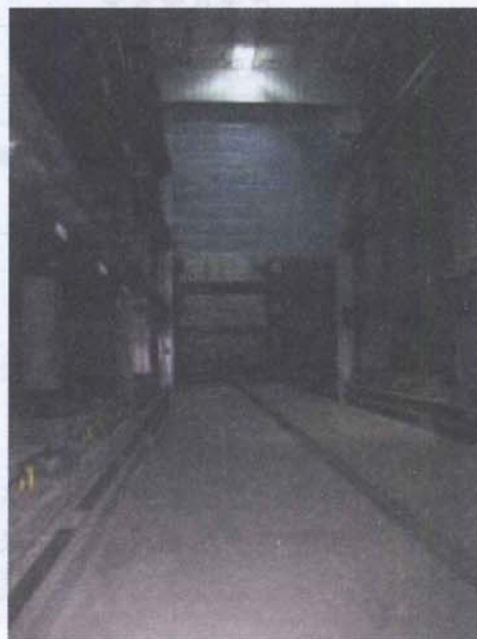
图E5-6 搬运台车运行通道
