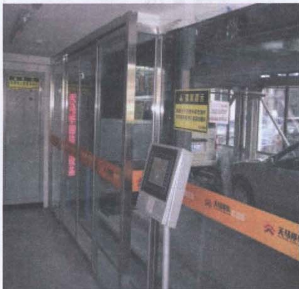
图E7-3 车库入口操作台
