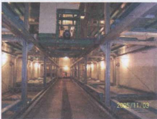
图E8-3 搬运台车通道
