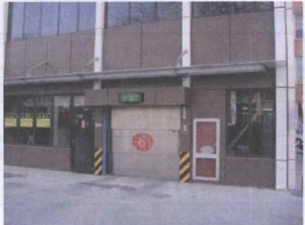
图E7-2 车库出入口（外部）
