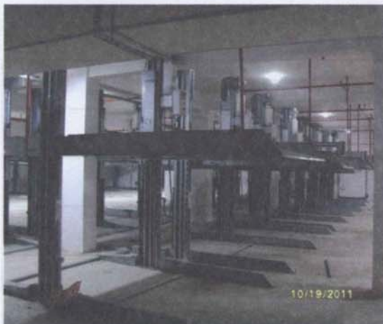
图B4-1 停车设备图（空载时）
