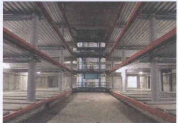
图E9-4 搬运台车通道
