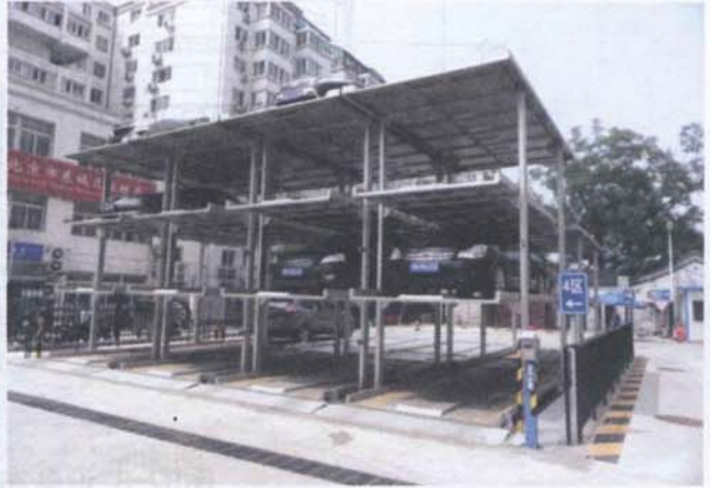
图B2-4 停车设备图（升起时）
