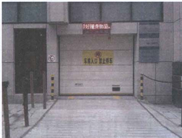
图E4-1 车库出入口(外部)
