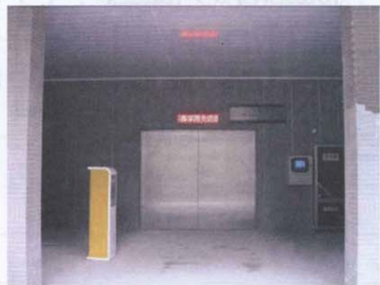
图C3-4 车库出入口(外部)
