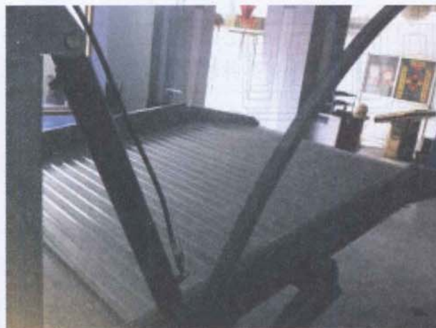
图B3-3 载车板（水平时）
