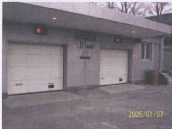
图E8-1 车库出入口（外部）
