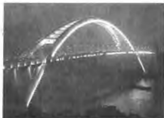
图 8-2 上海卢浦大桥
