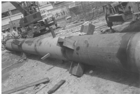
图 5-189 工厂制作完成后的内加强环式梁-柱节点
