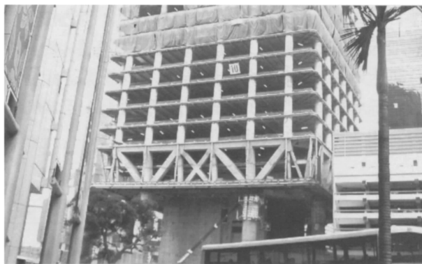
图5-200 转换层钢管桁架
