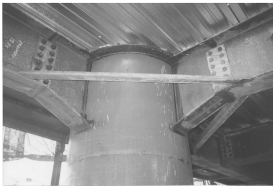
图 5-190 钢梁与钢管混凝土柱的拼接
