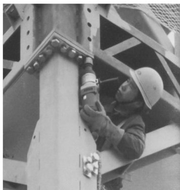
图 1-14 钢结构固
