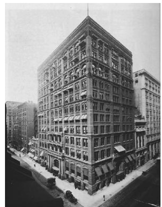
图 1-1 家庭保险大楼 (Home Insurance Building) 世界第一座高层钢铁结构建筑 (1883 年,芝加哥, n=11 层, H=55m )
