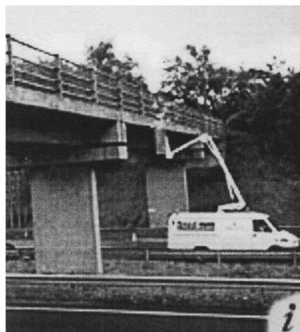
图 1-8 Stainsby Hall 大桥
