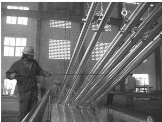
图 3-20 热浸镀锌实际操作情况
